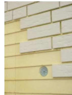
Eine mit Klinker-Riemchen ausgeführte Ziegel-Fassade. Sieht nicht nur gut aus, solange sie neu ist, sondern bleibt auf Dauer auch so. Da kann man schon mal ein Fahrrad anlehnen, ohne gleich Beschädigungen der Wand befürchten zu müssen. Bei Putz wäre das vielleicht etwas anders.
