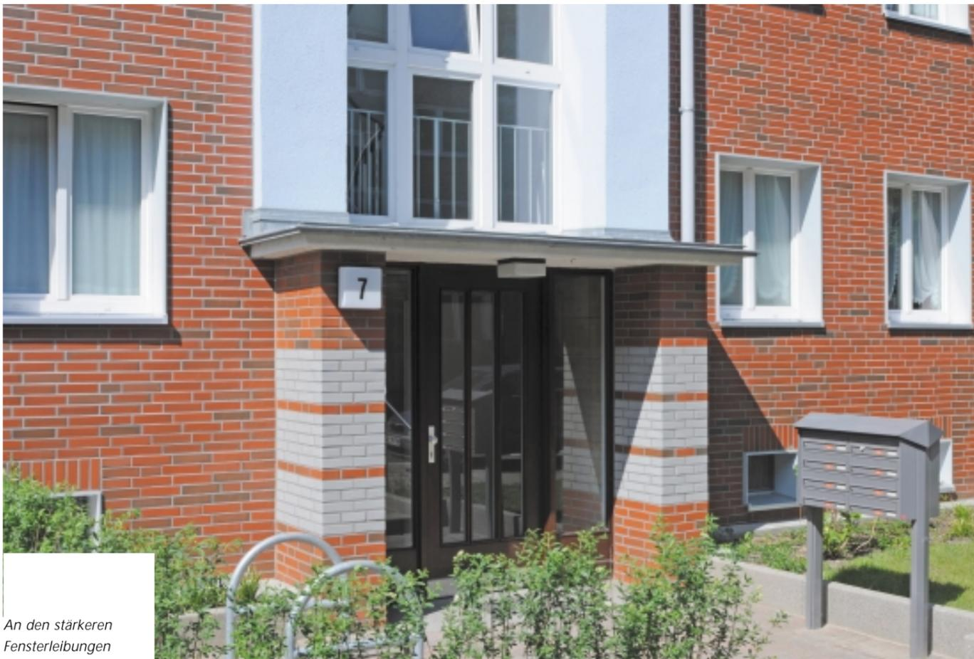
An den stärkeren Fensterleibungen gut zu sehen: Hinter der neuen Klinker Riemchen-Fassade verbirgt sich die Wärmedämmung.
