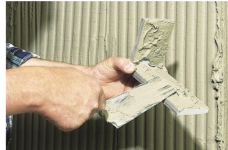
Setzen der Flächenriemchen mit Hilfe einer Schnur.
