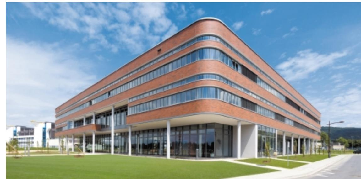
*Röben Klinker-Riemchen lassen sich so perfekt verarbeiten, dass kein Unterschied zu massivem Mauerwerk erkennbar ist. Besonders gut zu sehen an der sauberen Ausführung der runden Gebäude-Ecken.*
